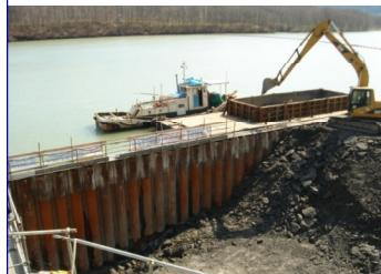
2009年4月 工区内部を掘削中、漏水ナシ
