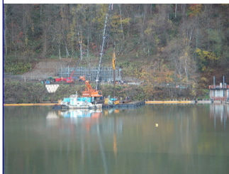
2008年10月現場遠景ダム湖の対岸から
