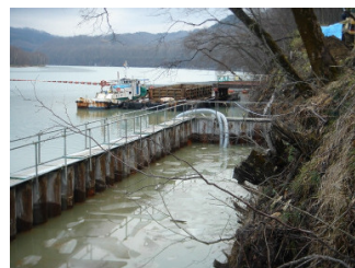
2008年12月 打設後水抜き前の状態
