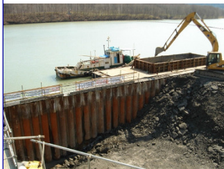
2009年4月 工区内部を掘削中、漏水ナシ
