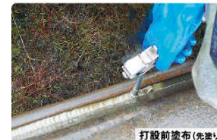
打設前塗布(先塗り)
